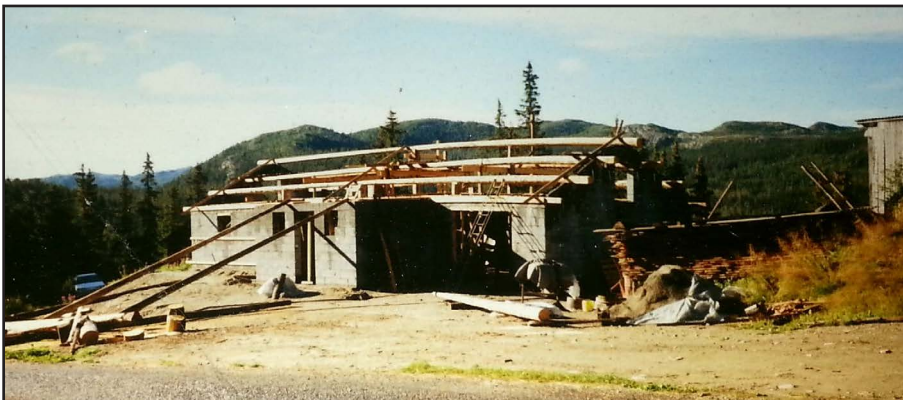
«Det var det som berga det – elt dugnadsarbeidet», sa Øystein om museumsbygget sitt. Her ser vi bygdemuseet under arbeid. Det sto ferdig i 1999.
