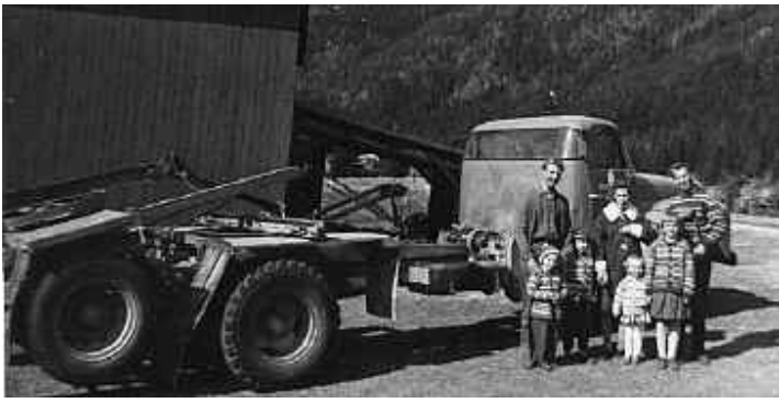
Figur 3 Olav Skårnes sin tømmerbil med totromlet vinsj plassert bak førerhuset
