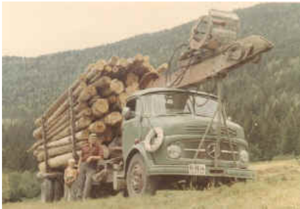
Figur 5 Mercedes tømmerbil med tidlig utgave av kran. Bildet er antageligvis fra rundt 1965-66
