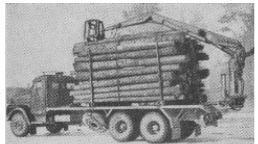
Figur 4 En tidlig utgave av Hiab sin "Skogselefant", tømmerkran for lastebil
